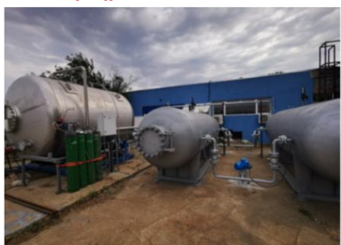
Rezervoare stocare azot (80 bar)
